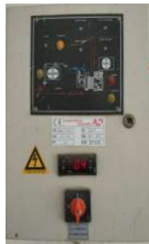
Εικ. 14 Καταγραφικό θερμοκρασίας ψυκτικού θαλάμου
