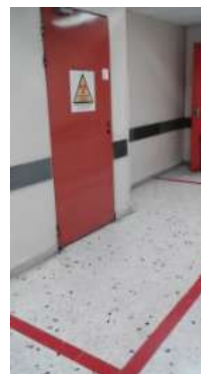
Εικ. 11 Είσοδος κεντρικού χώρου ακαθάρτων
