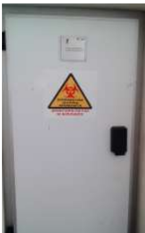
Εικ. 12 Είσοδος ψυκτικού θαλάμου Αποθήκευσης ΕΑΑΜ & ΕΑΜ
