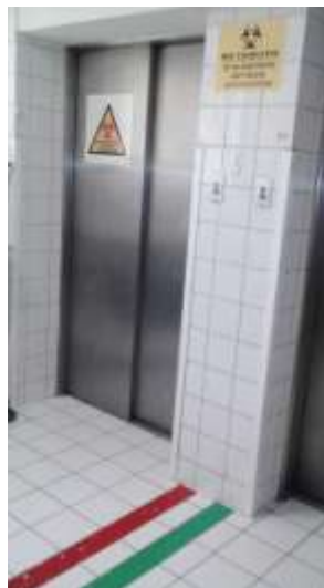
Εικ. 10 Ανελευστήρες μεταφοράς Αποβλήτων Υγειονομικής Μονάδας
